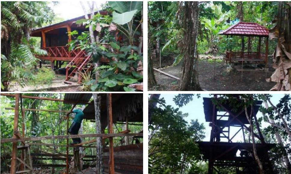
Gambar 83 Cottage yang telah dibangun di Isyohill (kiri atas); gazebo (kanan atas); pembangunan dapur umum (kiri bawah); dan menara pengamatan burung (kanan bawah)
